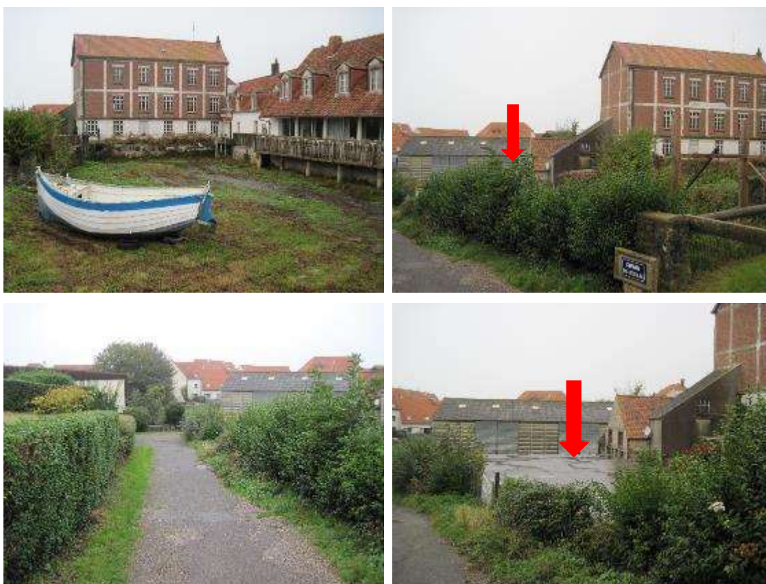
Il s'agit de la construction controversée d'un hôtel avec parking souterrain entre le musée du Moulin et le chemin du Moulin en plein centre-village. Chemin menant à la mer très fréquenté par les promeneurs.
